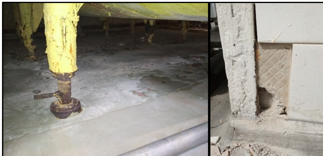
Рис. 5. Состояние пола (слева) и колонны (справа)
